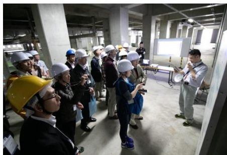
茨城県流域下水道事務所霞ヶ浦浄化センター
